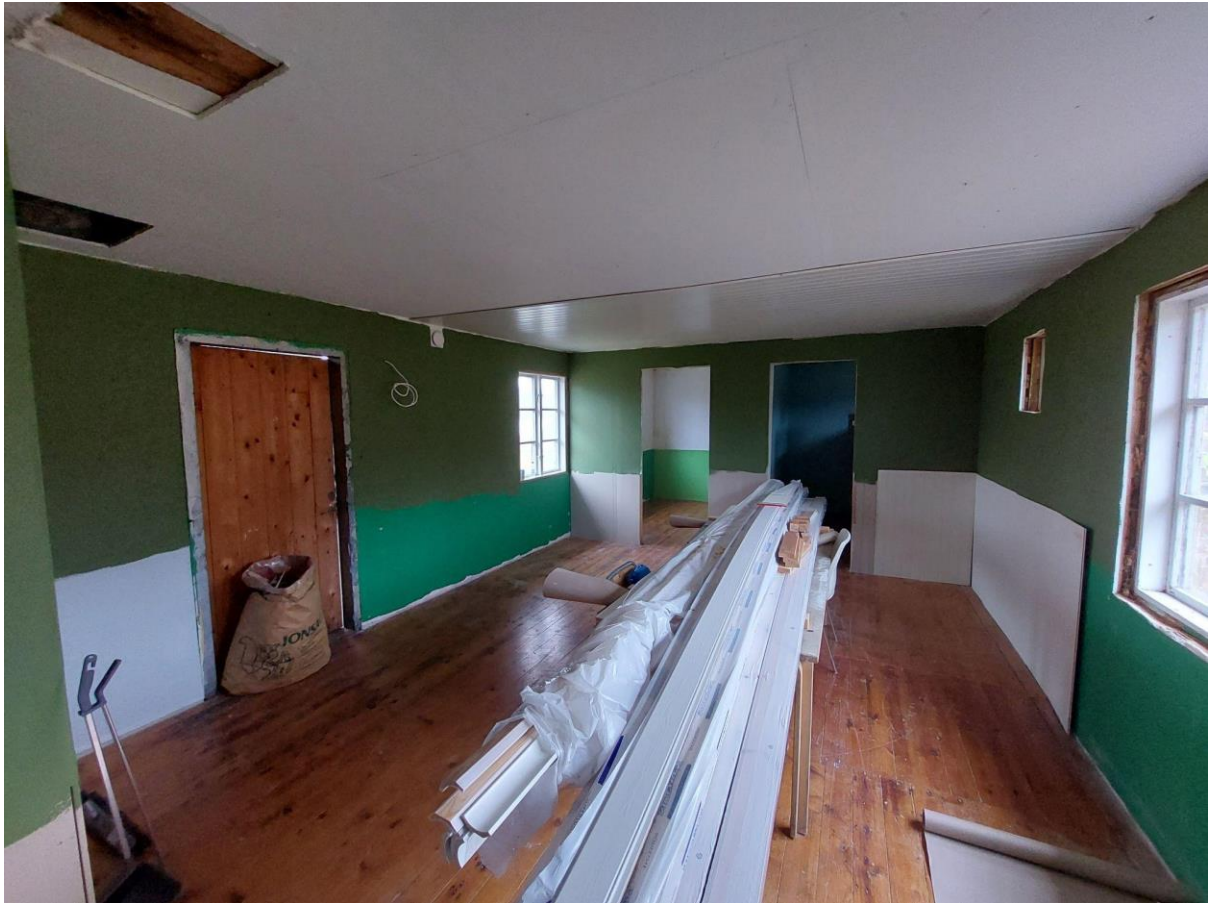
Bild 4 - Matsal/vardagsrum med takpanel delvis uppsatt samt några skivor bröstpanel till höger i bild. Takpanel, lister m.m. ligger på arbetsbordet i mitten.
