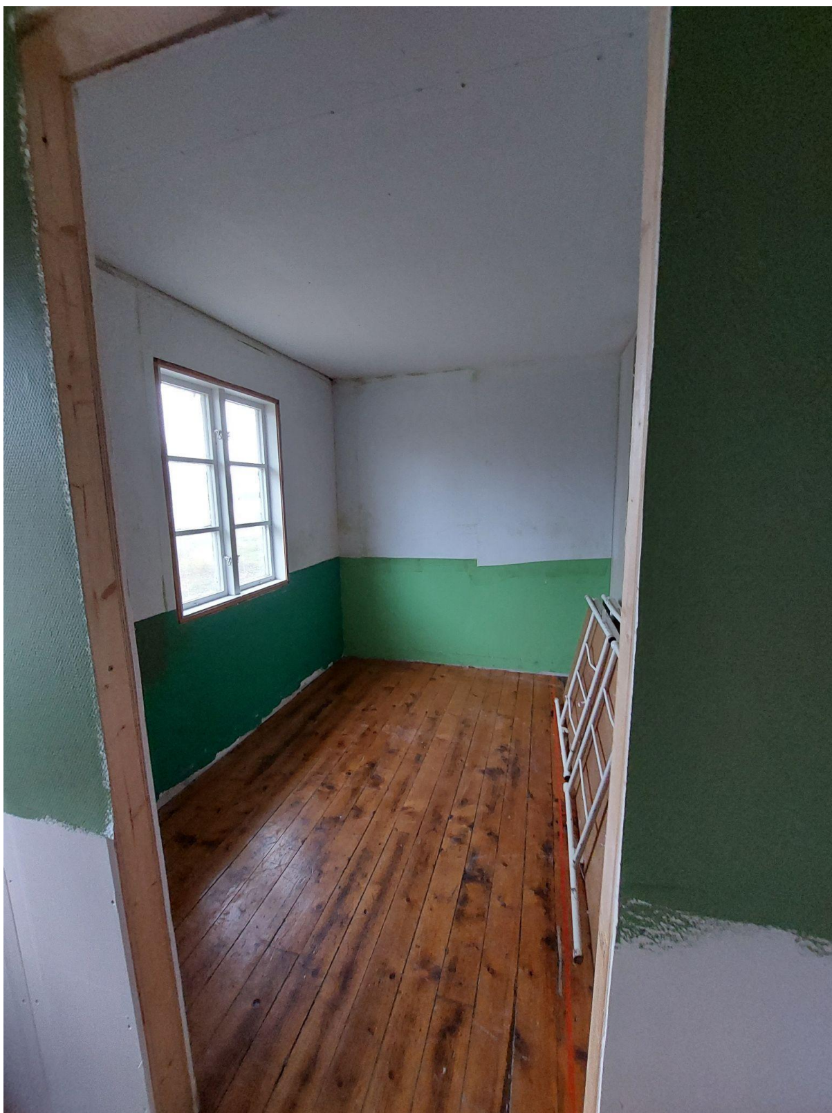
Bild 2 - Stora sovrummet med renoveringstapet innan uppsättning av tapet och bröstpanel.
